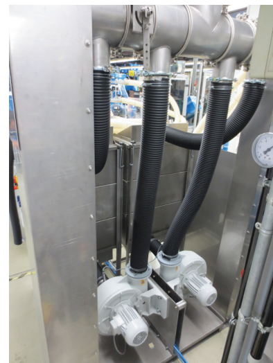
SL7008 Box 2 x 4 Absaugarme für die punktuelle Absaugung im Maschinen-(Anlagen)raum
